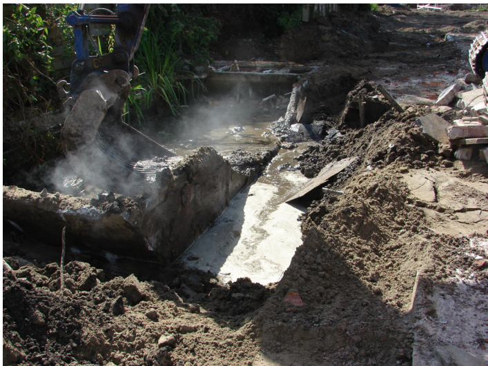
Afb. 2: het verwijderen van een betonnen vijver in het oostelijke deel van het plangebied tijdens de archeologische begeleiding.
