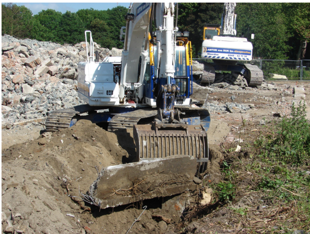
Afb. 3a: het verwijderen van de betonnen funderingsbalken op de onderzoekslocatie.
